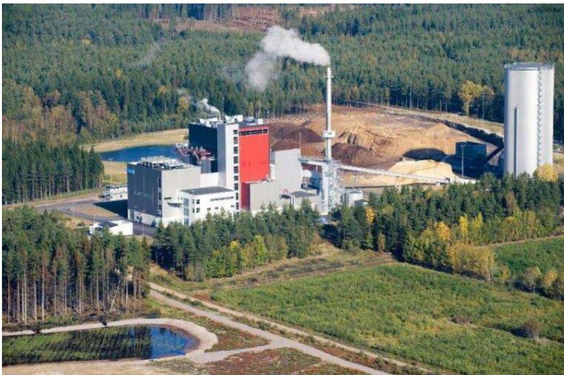
Figur 1. Foto över anläggningen.
